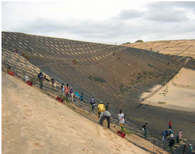
急斜面にはネットを張って砂を止める
