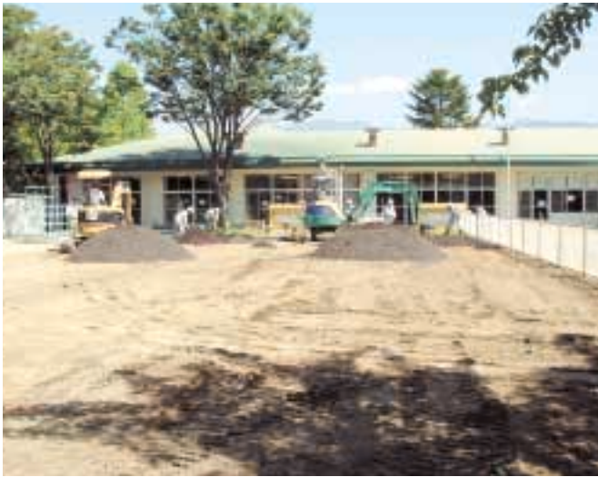
園庭を掘り起こして新しい土を運び込みます
