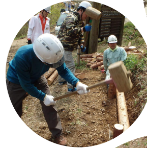
4月15日 ▼木柵設置の様子
