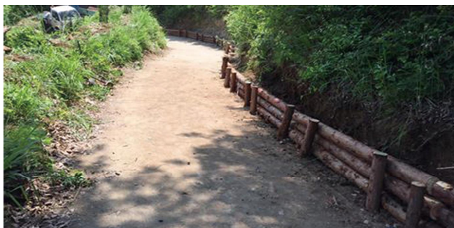
▲5月25～26日木柵設置
