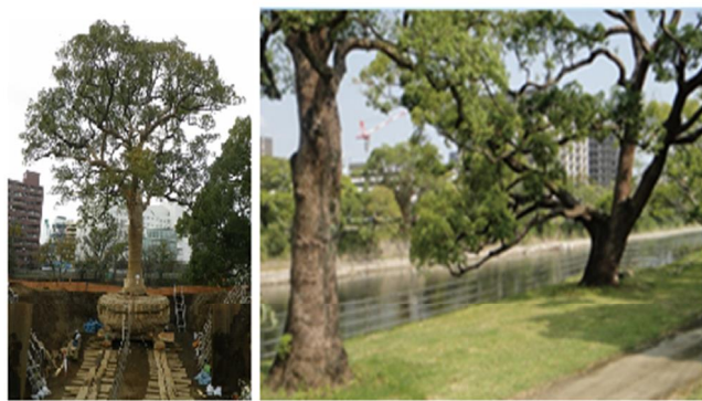
▲熊本初の立曳で河川改修に伴うクスの大木を移植 (大手企業が地域企業に伝統工法の技術移転)
