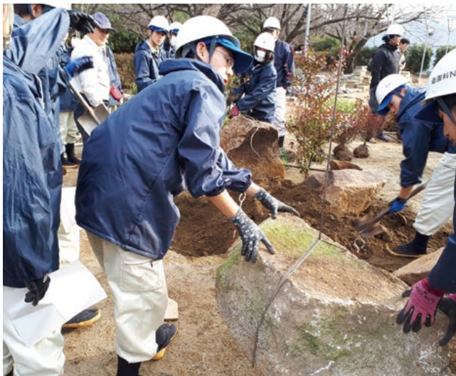
▲ ワ이어吊りで石組み
