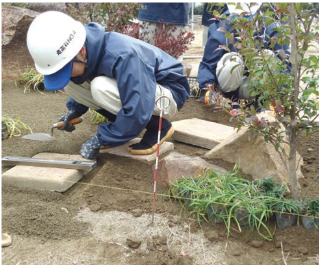
▲ 水平器を使用して飛び石の設置
