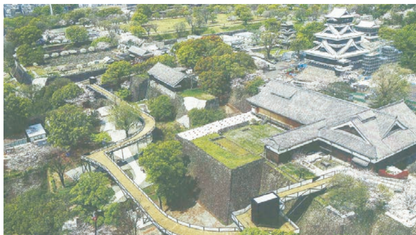
▲ 写真4 熊本地震後の熊本城復旧と仮設の見学通路 (出典：建設通信新聞 2020年5月20日号より)
