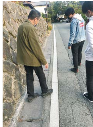
▲ 写真11 街づくり環境整備事業 石材を利用した白線
