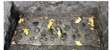
▲ 写真8・9 街づくり環境整備事業による坂道のデザイン再生 徳永氏の手作業による砂利の埋め込み
