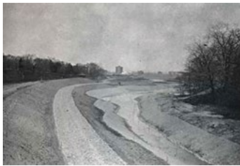
▲ 写真5 緩傾斜護岸を導入し、河川改修が行われた(1880年代)
